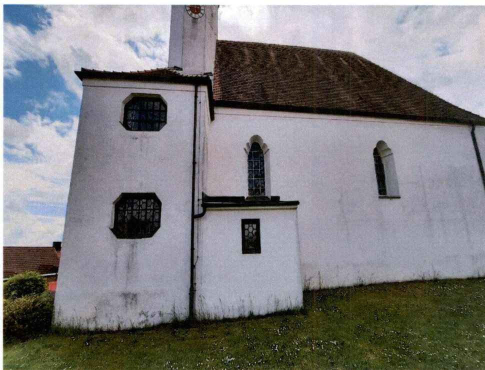
Ansicht Fassade Nordseite
