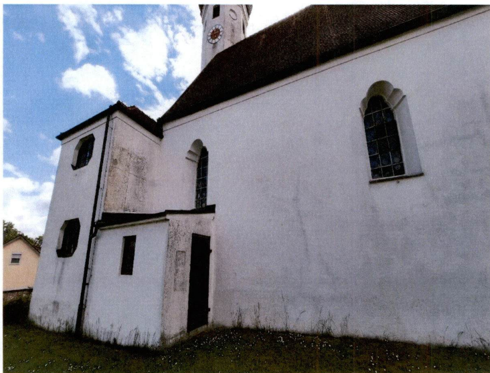
Ansicht Fassade Nord-Westseite
